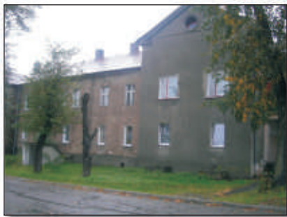
Stan obecny budynku Zarządu Kopalń w Ostrowach Górniczych. Foto: Jerzy Gołębski
