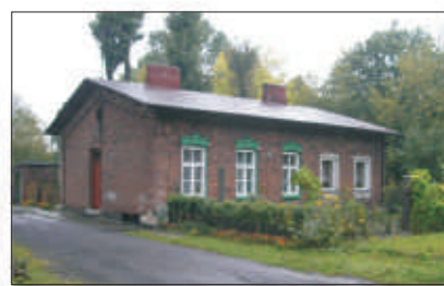
Budynek pawilonu zakaźnego (widok obecny). Foto: Jerzy Gołębski
